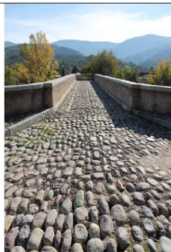
Pont de Ponte Novu, Castello di Rostino, Corse
