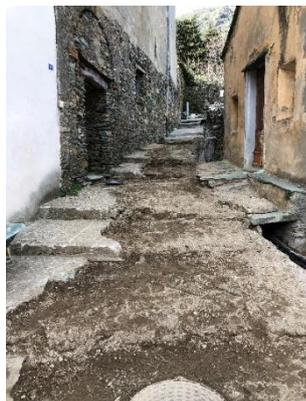
Le tuyau a été remplacé de la chapelle à la place, en passant par le camarottu sur une longueur de 70m. Ces travaux étaient impératifs car les eaux claires parasites arrivant à la station d'épuration étaient trop importantes.
